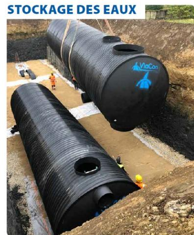
Figure 6 : Exemple de cuve de rétention (p. 2 Annexe 7.d)
