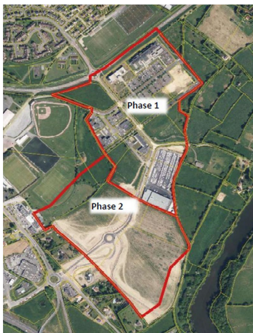
Figure 2 : Vue aérienne des phases du projet (p.9 Pièce 2-2-2-14_dossier loi sur l'eau_avec annexes)
