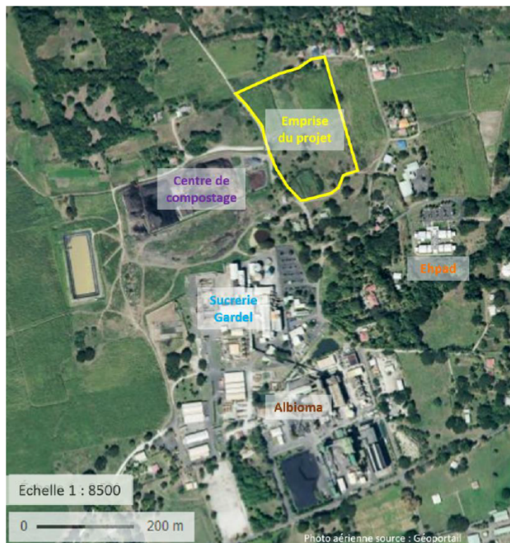
Photographie aérienne du site du projet (Source : étude d'impact)
