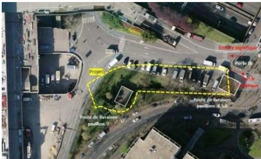
FIGURE 4 : VUE AÉRIENNE DE L'EMPRISE DU PROJET HÔTEL VANVES (ETUDE D'IMPACT - TOME A, P.12)
