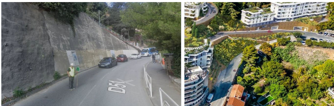
Figure 4: A gauche : vue sur le mur en béton existant depuis la D51 – Source : Google StreetView A droite : Zoom sur l'insertion du projet dans le site selon PC6 , le mur en béton semble végétalisé sur le photomontage alors que cette zone est a priori hors périmètre projet.
