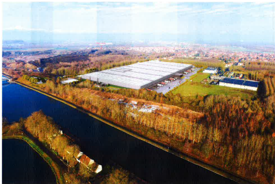
VUE AERIENNE DEPUIS LA DEÛLE
