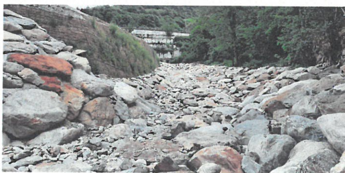
Chenal et enrochement - vue depuis la voie Romegiero
