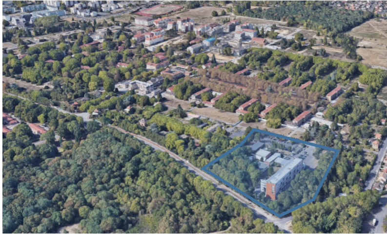
L'IFITS et le site de Maison Blanche à Neuilly-sur-Marne - vue aérienne Google-Maps.
