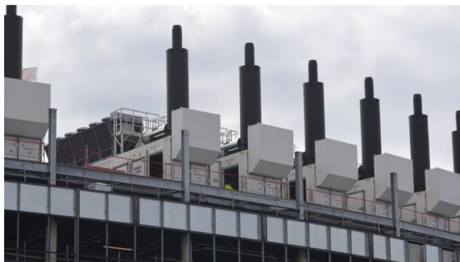
cheminées de sortie des groupes électrogènes installés sur le centre de données en cours de construction à La Courneuve (source MRAe).
