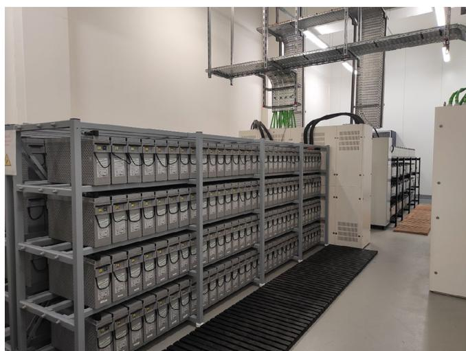
Les centres de données exigent un très haut niveau de sécurité et de fiabilité des installations. Ici, une des salles de stockage de l'énergie pour répondre immédiatement à la moindre défaillance du réseau électrique (source MRAe-IdF).
