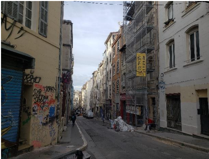
Gestion des déchets de chantier très contrainte dans des rues
