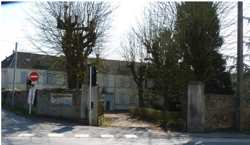
Vue du site depuis la route de Bel Air
