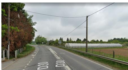
Les serres et vergers face au site, de l'autre côté de la RD30
