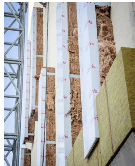
Isolation de façades en laine de roche Daniel COUTELIER /TERRA
