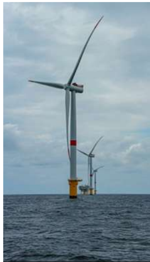
Parc éolien en mer de Fécamp et sa sous station électrique (76) Maud VARIN ENSAM / TERRA
