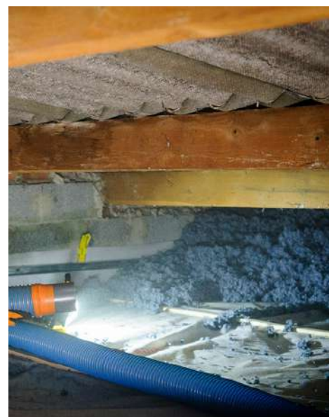
Pose isolant thermique dans des combles Arnaud Bouissou / TERRA
