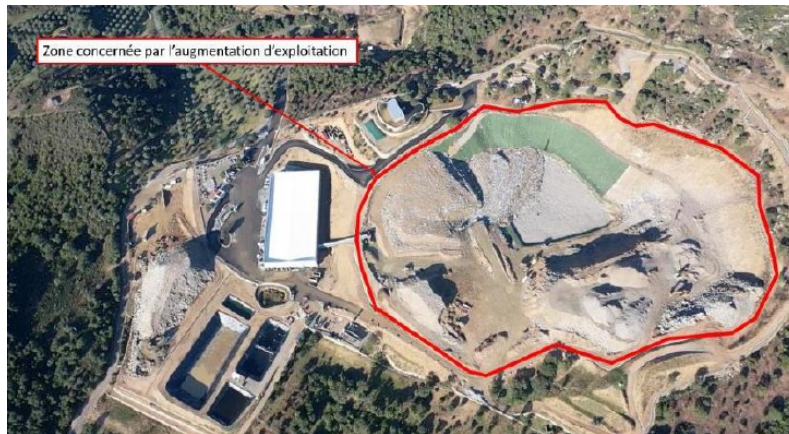
Figure 2. Vue en drone du casier actuellement exploitée et concernée par la modification (à gauche : le centre de tri, les bassins de lixiviats et d'eau pluviale)
