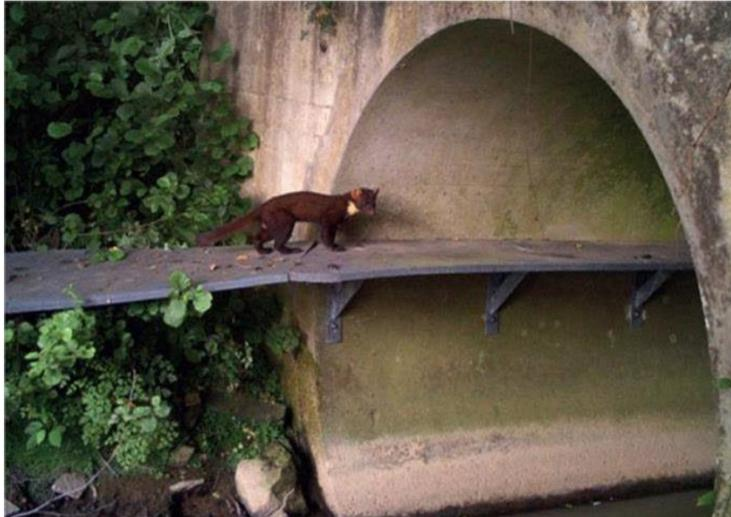
Figure 5 : modélisation d'un ouvrage hydraulique avec banquettes et illustration d'une banquette en encorbellement (source : étude d'impact)
