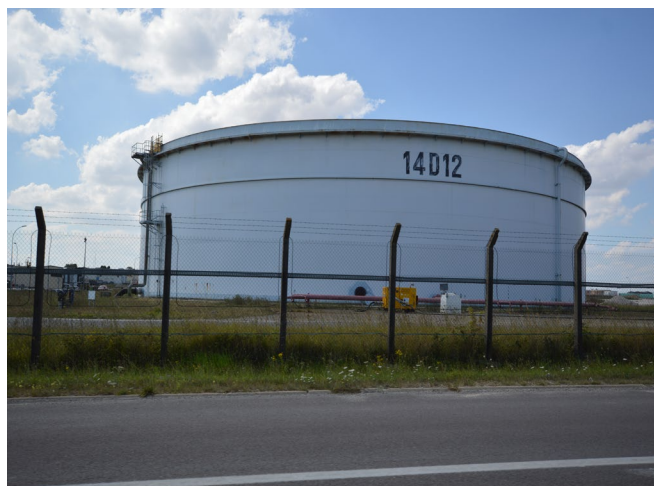
Citerne de stockage sur le site de Grandpuits
