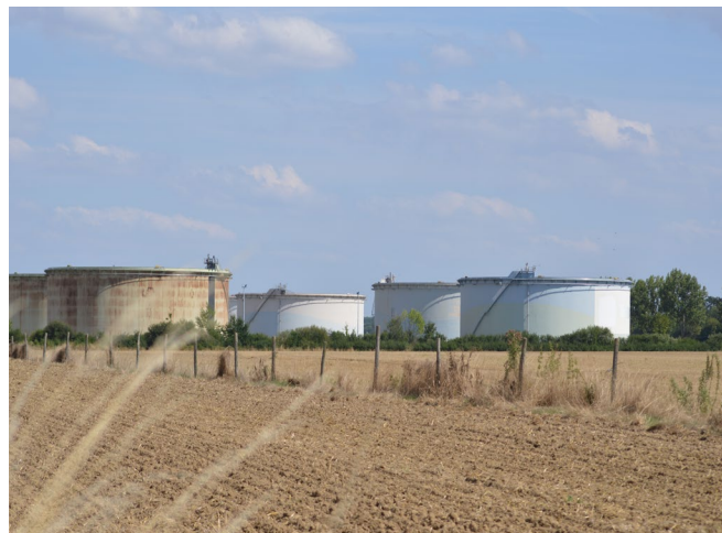
Secteur dédié au stockage
