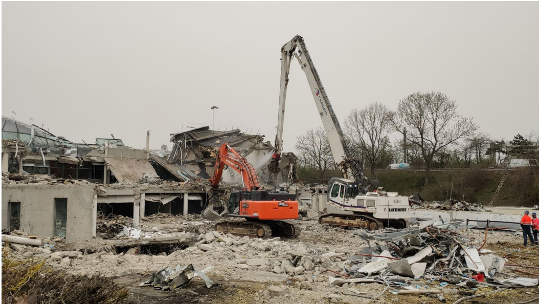
La MRAe examine comment réduire les nuisances de chantier et les risques de pollution de l'environnement
