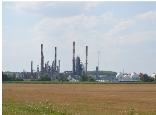
Usine de Grandpuits (partie transformation)
