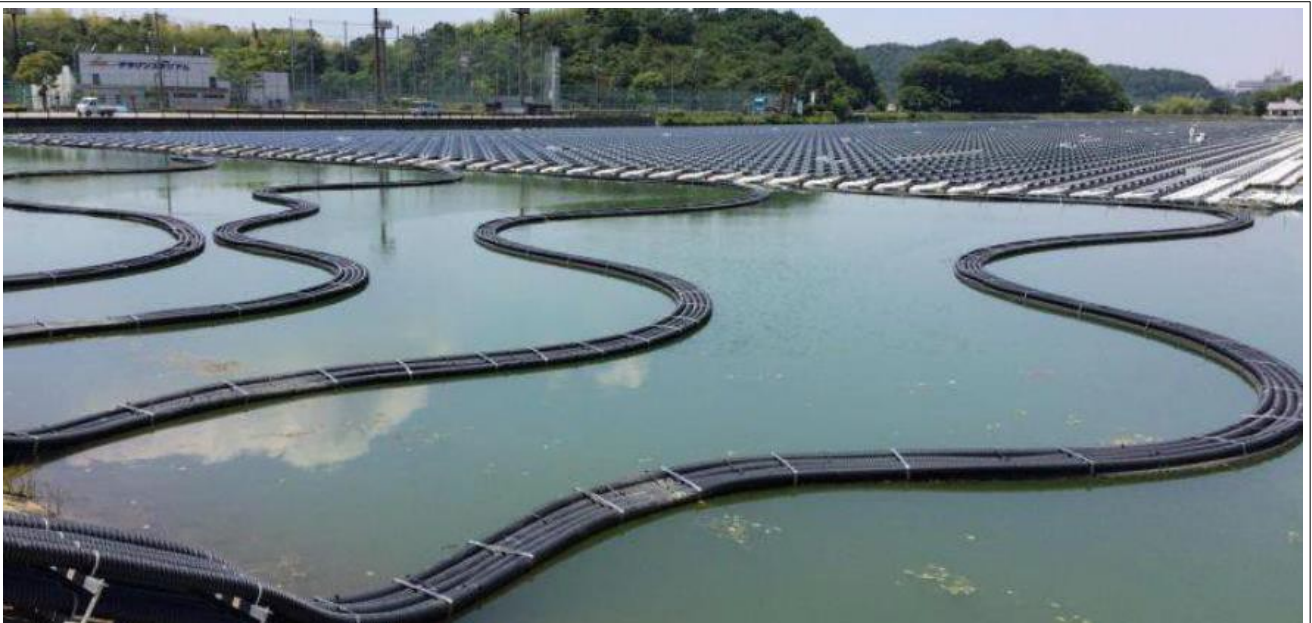
Exemple de câble avec gaine flottante, étude d'impact page 59
