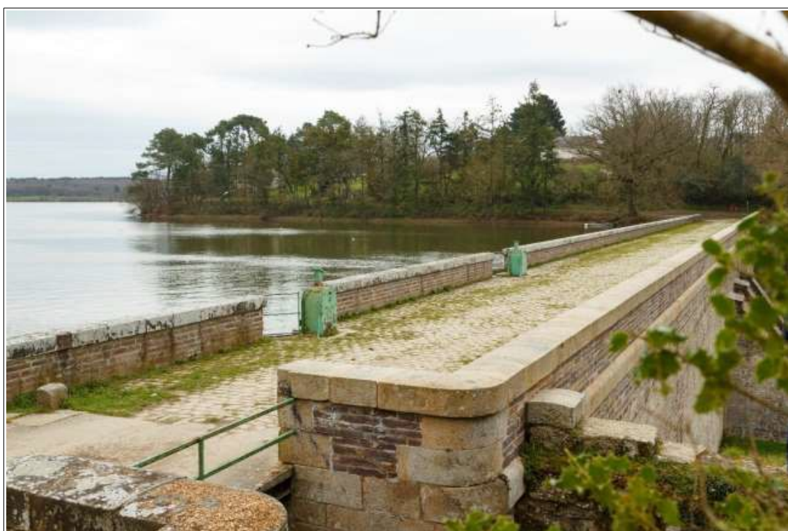
Vue depuis la rive droite sur le barrage (source : Étude d'impact, page 576)
