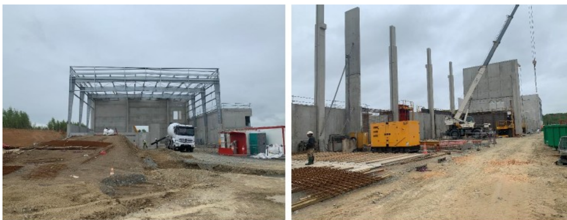
Construction bâtiment ligne de sur-tri (avril 2023)
