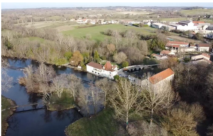
Figure 3: Vue sur le Moulin et la centrale hydroélectrique communale (source :Évaluation environnementale, p.12)
