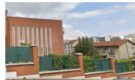
Clôture sur muret étagé rue des Garmants
