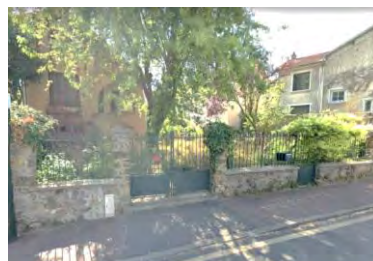
Clôture sur muret non étagé rue des Garmants
