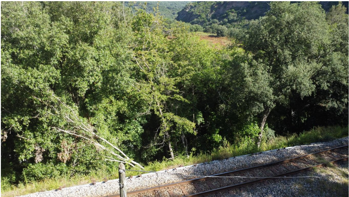
Figure 10 Prise de vue depuis la voie ferrée
